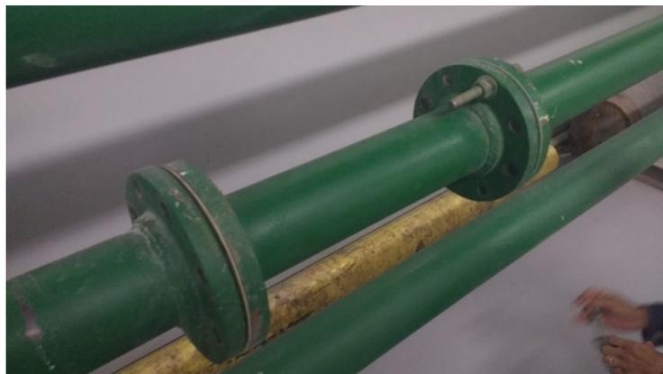
**Figura 17:** *Spool* inserido entre trechos de 6 metros de tubo – onde foram inseridos os bloqueios
